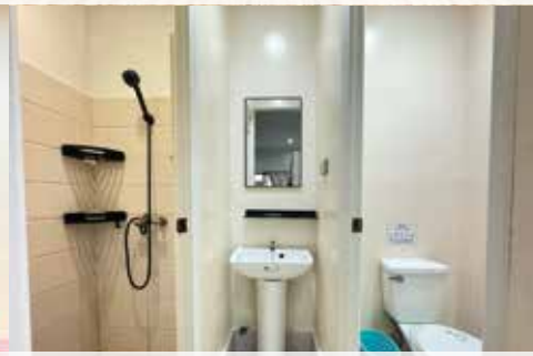
トイレ & シャワールーム
